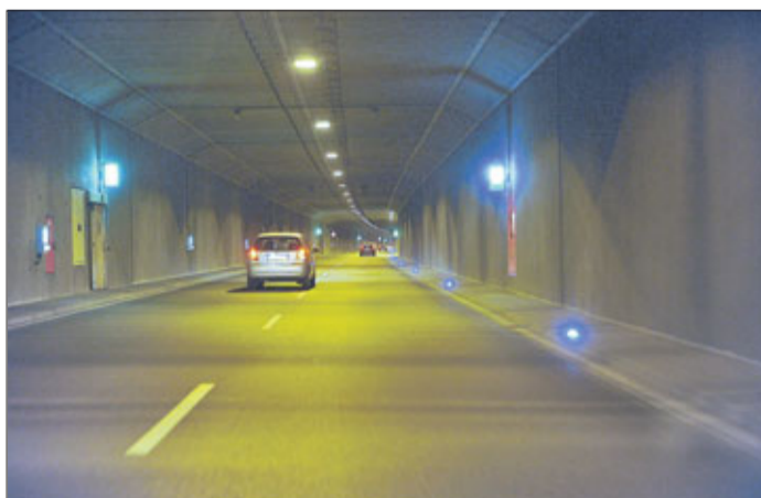
An 181 von etwa 900 Tagen seit April 2010 war der Weserauentunnel zumindest teilweise nicht nutzbar. Foto: MT-Archiv
